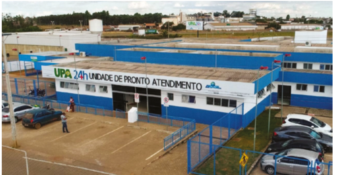
Unidade de Pronto Atendimento da Vila Esperança (UPA Alair Mafra), beneficiada com os novos hospitais
