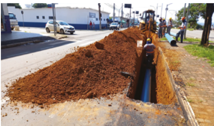
Entre as solicitações da Agência estão o registro da data de abertura dos cortes no asfalto ou na calçada, bem como a data de fechamento deles
